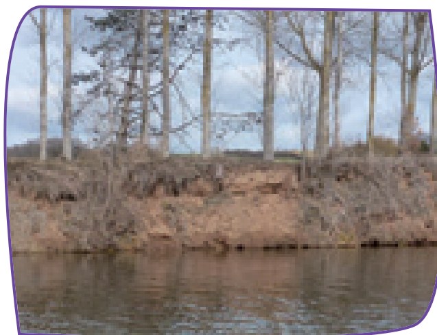
Erosion et peupliers sur la berge : végétation mal adaptée.
