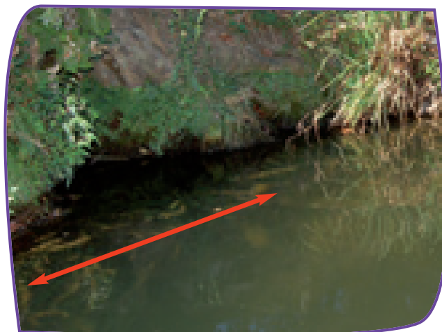
Berge sous cavée.
